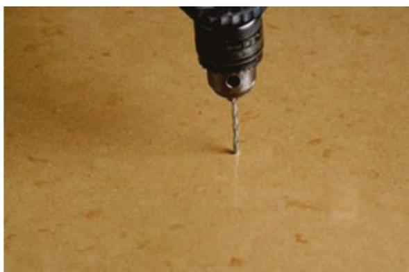
2. Тщательно просверлите примерно одну треть глубины столешницы в центре дефекта сверлом малого диаметра.
