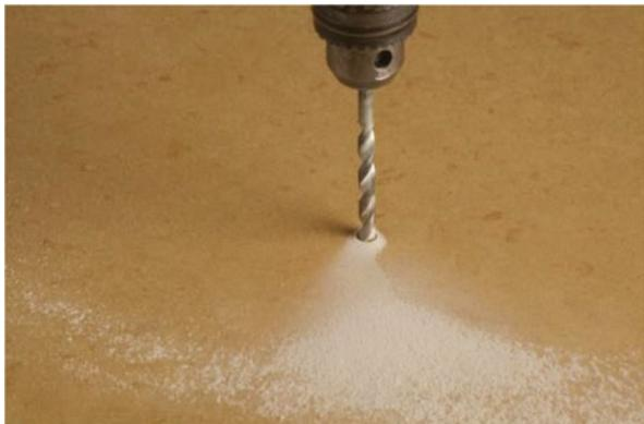
4. Высверлите дефект в столешнице примерно на половину ее глубины.
